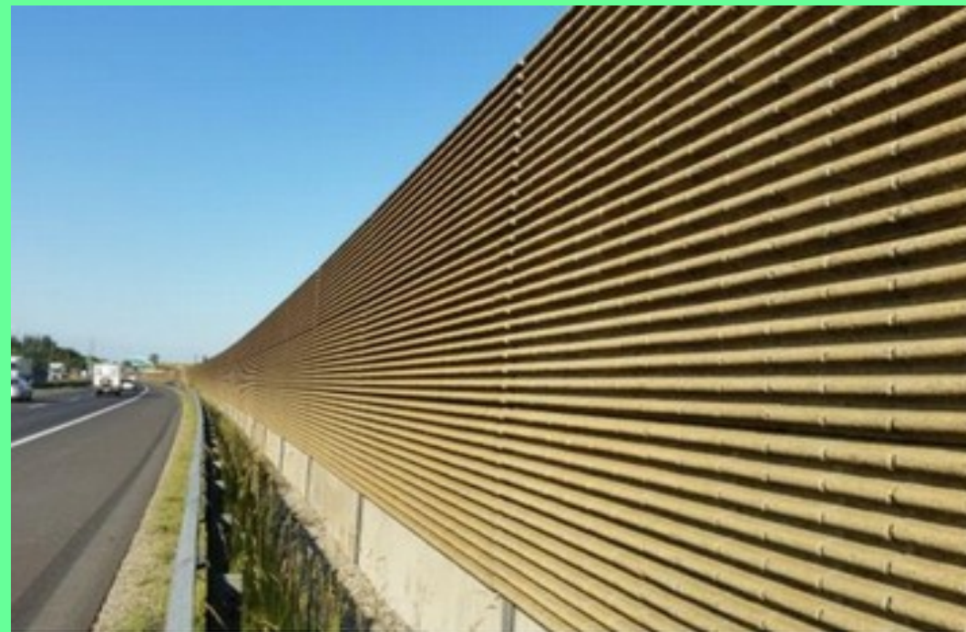
Vorgesehene Holzbetonwand A25 Pucking
