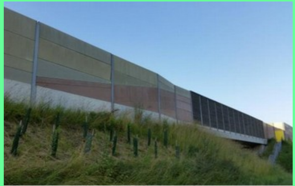
Vorgesehene Holzbetonwand A25 Pucking
